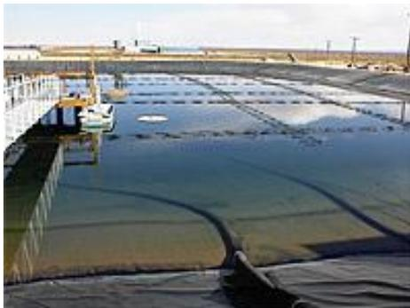
Рис. 4. Дно Солнечного пруда из глины и полиэтилена
